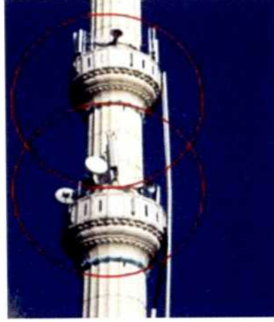
Şekil 1.6. Minare duvarına anten montajı yapılan bir baz istasyonu
